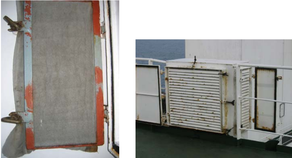
Abbildung 9: Beispiele für sichtbare Hygienemängel.
