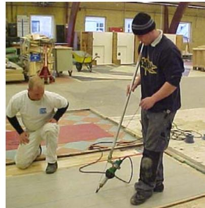
Weitere Arbeitsmittel zur Reduzierung der Arbeitsanteile im Knien gibt es z. B. für die Parkettlegearbeit. Beim Vernageln der Parkettstäbe kann man auf ein Nagelgerät zurückgreifen (Abbildung 20, siehe Seite 70), das bei abgestützter Vorbeugung des Rumpfes die rasche Durchführung dieser Tätigkeit erlaubt. Allerdings sollte bei diesen beiden Tätigkeiten (Nägel einschlagen und abstützen) regelmäßig von einer auf die andere Hand gewechselt werden.
