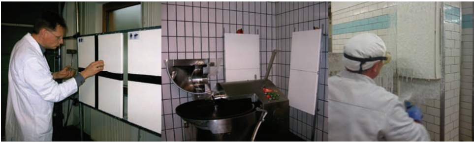
Hygienisch unbedenkliche Lärmabsorberplatten für Fleischereibetriebe (Bilder: R. Schmidt, Fleischerei-Berufsgenossenschaft)
