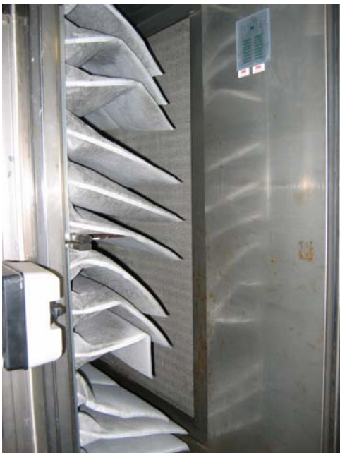
Abbildung 12: Einbau eines Taschenfilters mit flächigem Kontakt zum Kammerboden.
