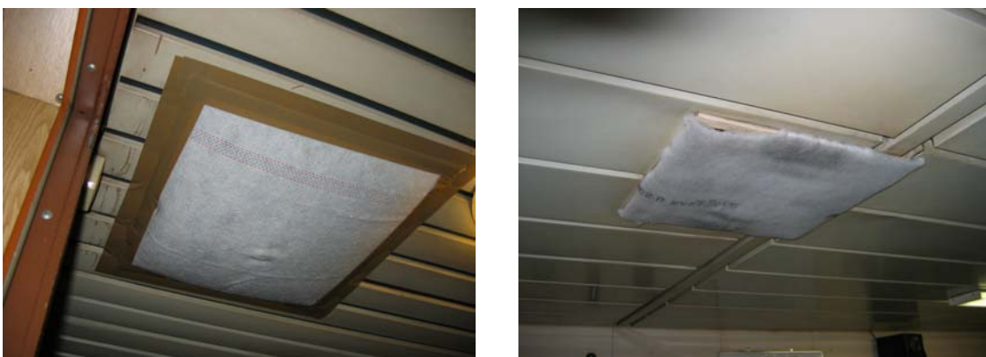
Abbildung 10: Zulüfter mit Wischlappen (links), Zulüfter mit Filtermaterial (rechts).
