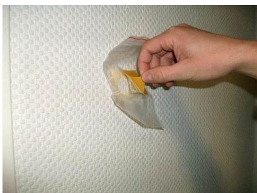
Abb. 5: Schutzfolie des doppelseitigen Klebebands auf der Vorderseite der Schleuse abziehen.
