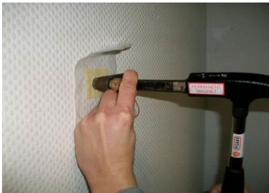
Abb. 7: Wandbekleidung durch die Schleuse ausstanzen.
