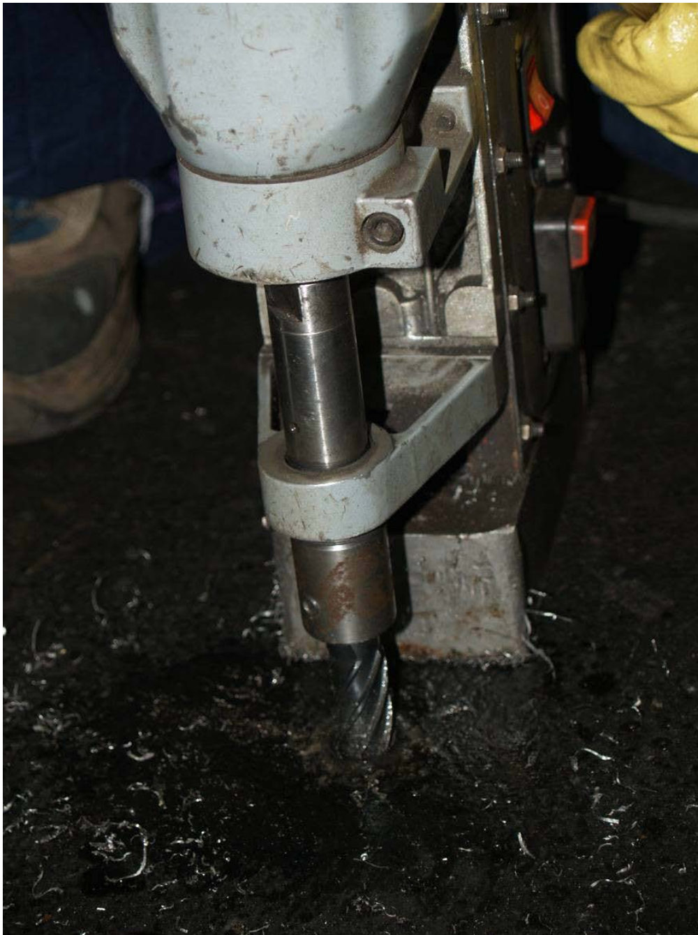
Aufreiben von Bohrungen an Blechen mit asbesthaltiger Altbeschichtung.
