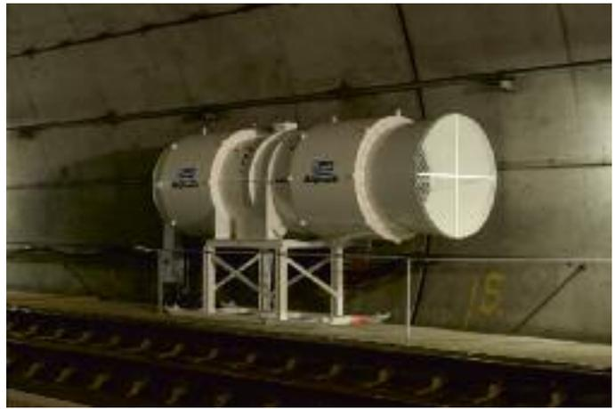
Abb. 10a und b: Lüfter auf dem Randweg im SFS-Tunnel mit Aufständering zur Einhaltung des Regellichtraumprofils und Umwegung für Reisende im Havariefall
