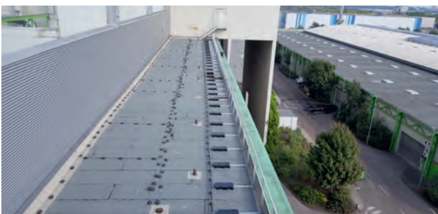
Abb. 8: Dachgeländer mit Auflast ohne Durchdringung
