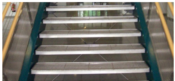
Abb. 2 Treppe ohne Setzstufe
