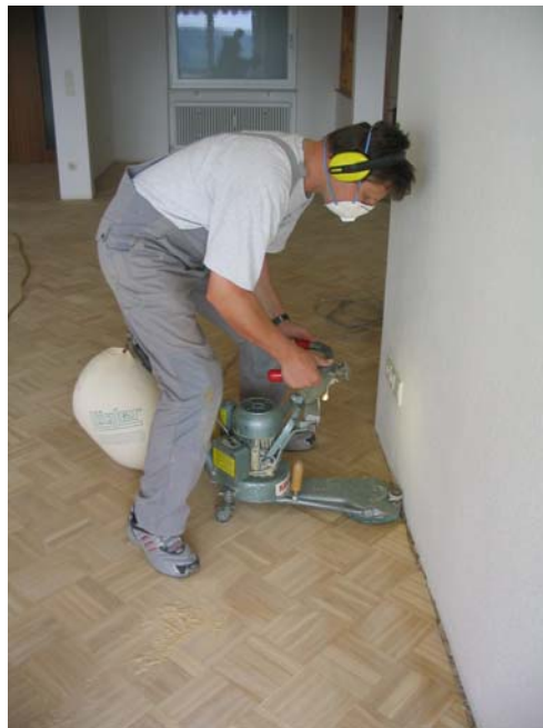
Abbildung 2-32: Zwangshaltung beim Parkettschleifen mit einer Randschleifmaschine
