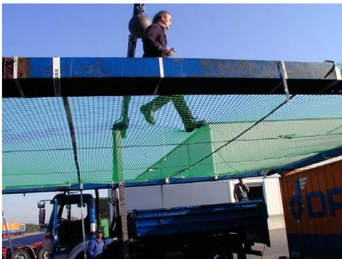
Abbildung Beanspruchung eines Arbeitsplattformnetzes durch eine darüber laufende Person
