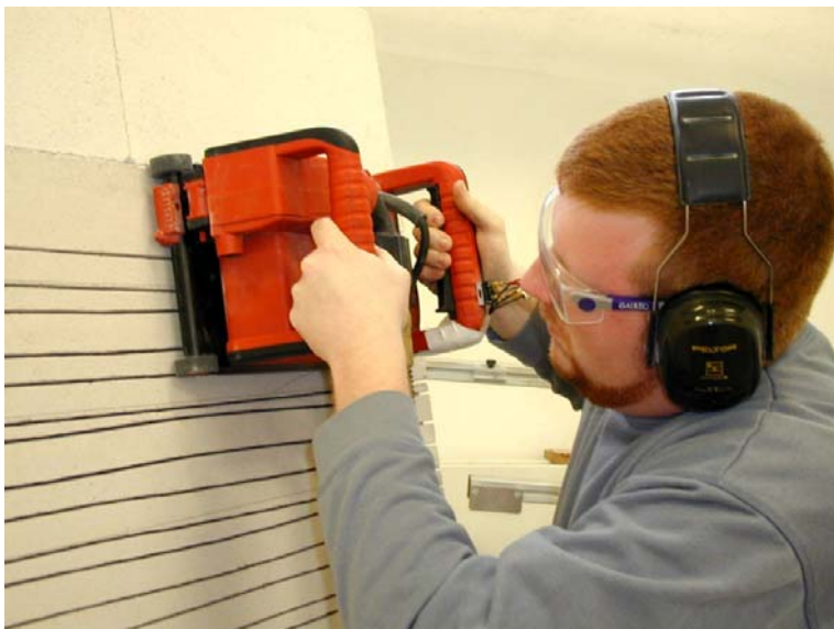
Abbildung Mauernutfräse beim Schlitzfräsen in Kalksandsteinmauerwerk
