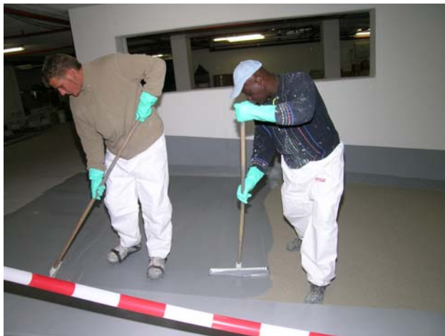
Abbildung 2-23: Aufbringen epoxidhaltiger Bodenbeläge
