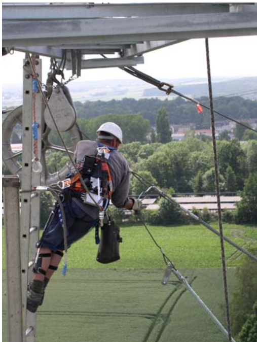
Abbildung 2-31: Messungen bei Arbeiten an Freileitungen
